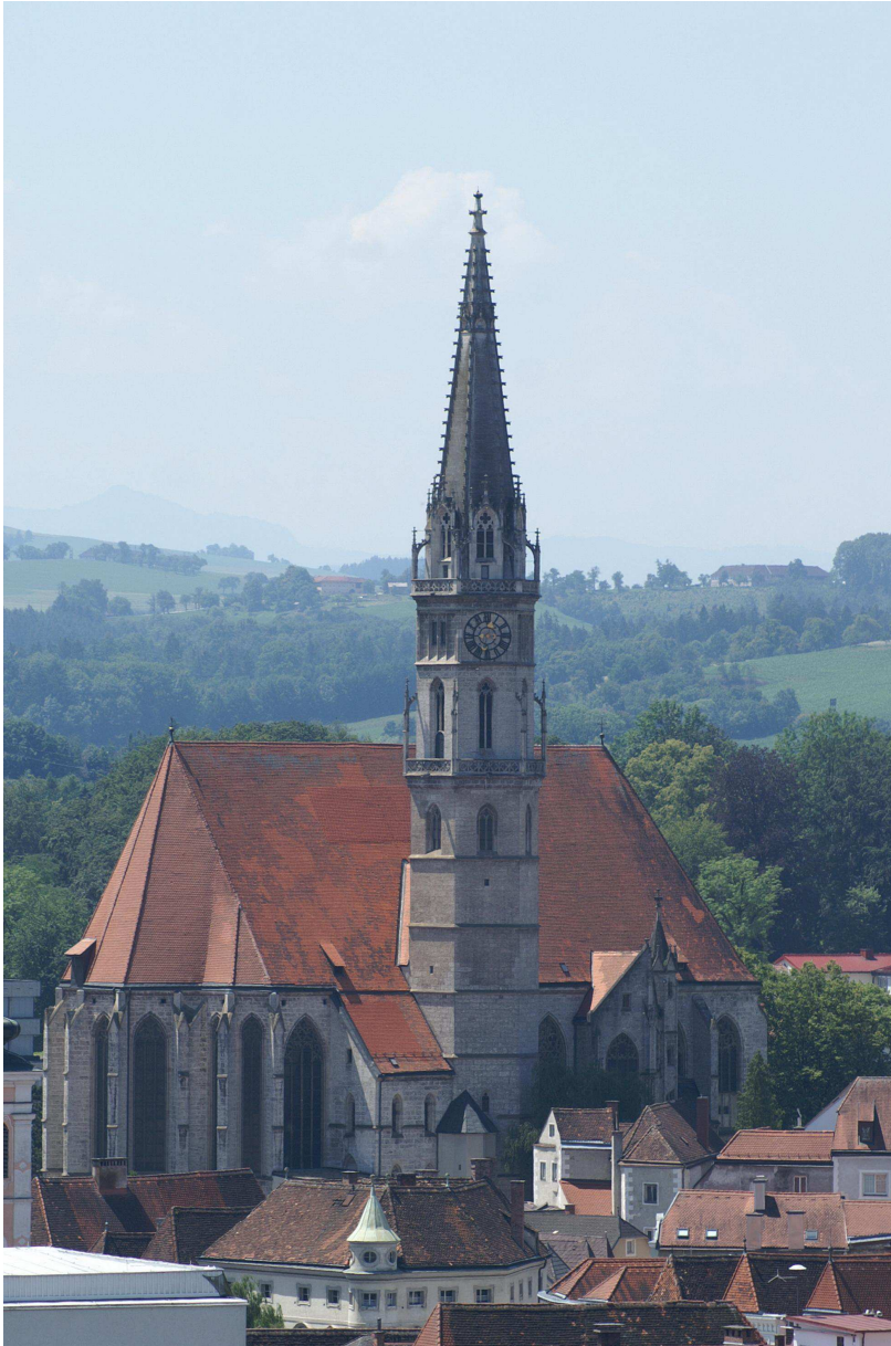
Abb. 4: Steyr, Stadtpfarrkirche, Ansicht von Nordosten mit Blick auf den Turm an der Nordfassade
