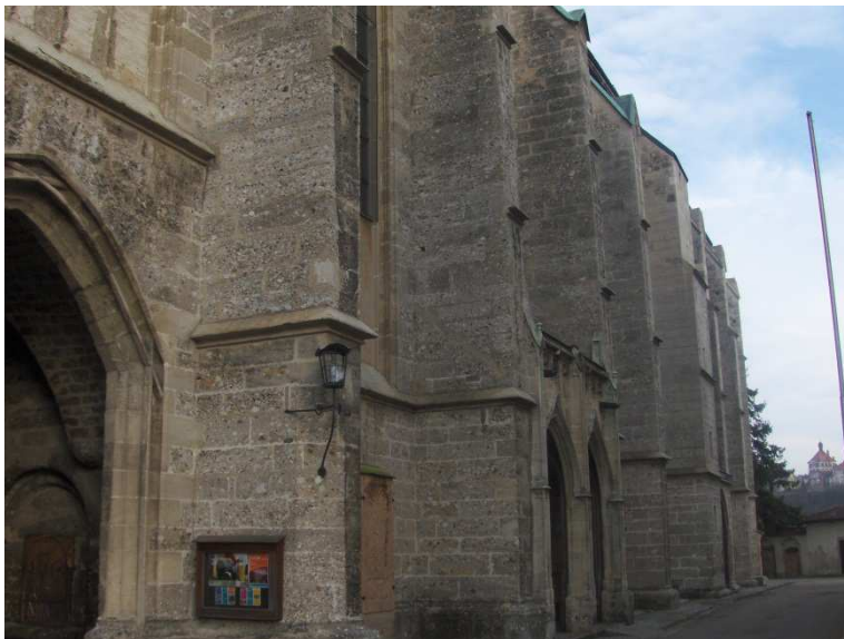
Abb. 9: Steyr, Stadtpfarrkirche, Südfassade, Strebpfeiler
