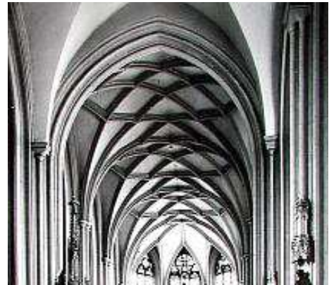
Abb. 10: Steyr, Stadtpfarrkirche, Mittelschiff, Chorgewölbe
