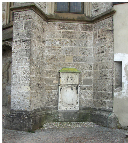
Abb. 6: Steyr, Stadtpfarrkirche, Detailaufnahme des Mauerwerkverbandes sowie des Sockelmauerwerks
