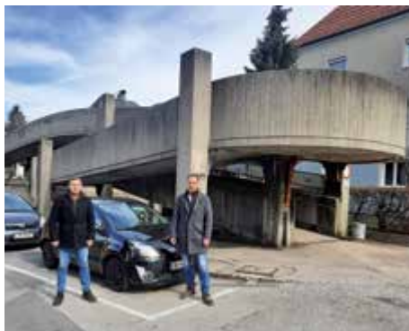
Der Neubau des Posthofüberganges wird noch heuer in Angriff genommen. Die nunmehr gebaute Variante war eine Idee von Gemeinderat Ing. Wolfgang Zöttl (rechts).
