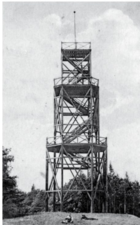
Vor 50 Jahren wurde eine neue Warte am Damberg errichtet. Das Bild zeigt den Vorgängerturm, der im Jahr 1934 aus Sicherheitsgründen abgetragen werden musste.
