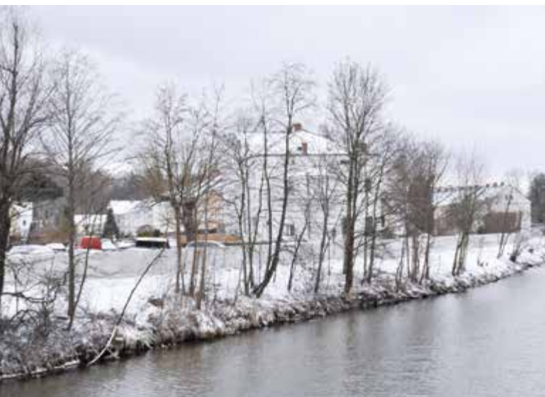
Im Wehrgraben und im Eysnfeld sind rund 1100 Laufmeter Ufermauern errichtet worden. Diese Bereiche werden in Zukunft vor großen Schäden durch Überflutungen sicher sein.
