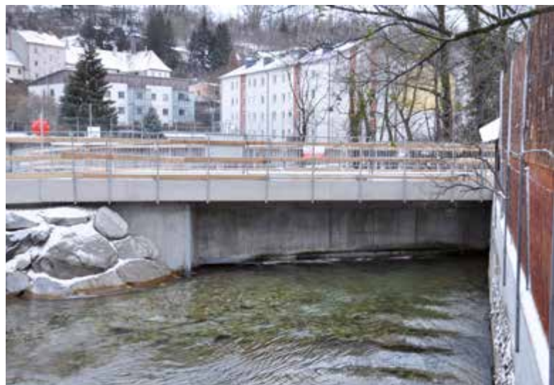
Die Baumaßnahmen im Wehrgraben waren der letzte Teil des gesamten Steyrer Hochwasserschutz-Projektes. Im Mittelpunkt stand dabei der Neubau der St.-Anna-Brücke als Drosselbauwerk.
