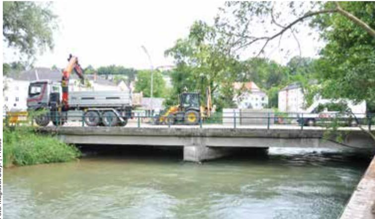
Die St.-Anna-Brücke wird als Drosselbauwerk neu errichtet. Das heißt: Die Durchflussmenge Richtung Wehrgraben wird verringert.
