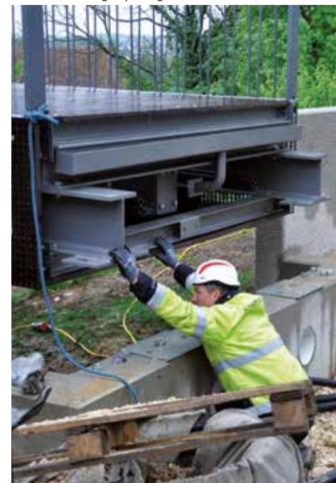
Foto unten: Das Einfädeln Richtung Auflagerbank erfordert viel Fingerspitzengefühl des Kranfahrers.
