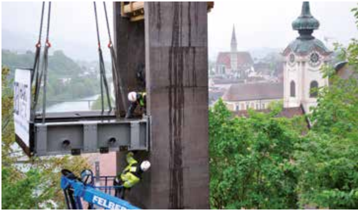
Bei strömendem Regen wird das erste Element der Metallkonstruktion am Liftturm montiert.
