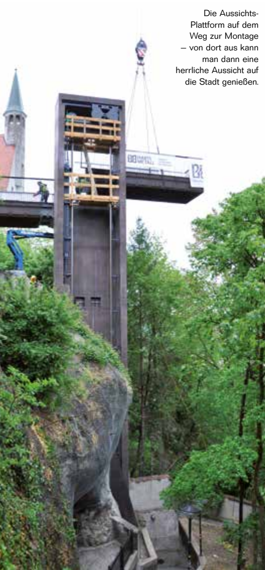
Der Kran hebt den Verbindungssteg ein.
