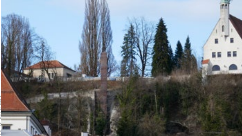
Der Panoramalift auf den Tabor (Bildmitte) steht kurz vor der Fertigstellung. Der Kran ist bereits abgebaut, der Leitungsbau abgeschlossen. Voraussichtlich Mitte Mai wird der Lift in Betrieb gehen.
