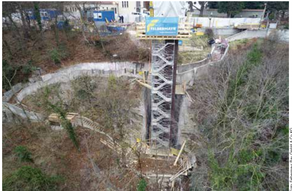
Blick auf den bereits errichteten Liftturm und die Taborstiege
