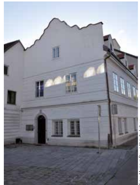
Gelungene Sanierung des ehemaligen Bürger- und Handwerkerhauses Wieserfeldplatz 15
