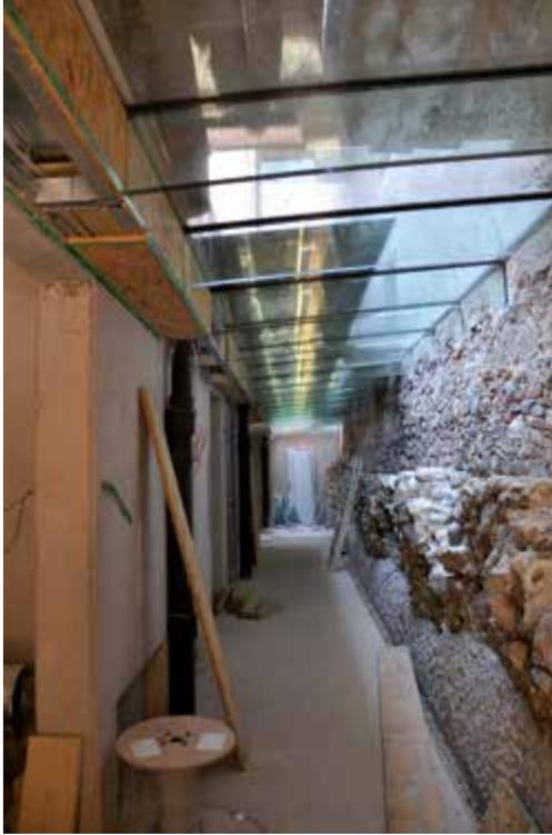
Der neue, mit Glas überdachte Gang zwischen Innerberger Stadl und Lift bringt optimale Belichtung und verbindet zeitgenössische mit historischer Architektur. Die Steinmauer rechts im Bild stammt noch aus dem Fundament des Speichergebäudes.
