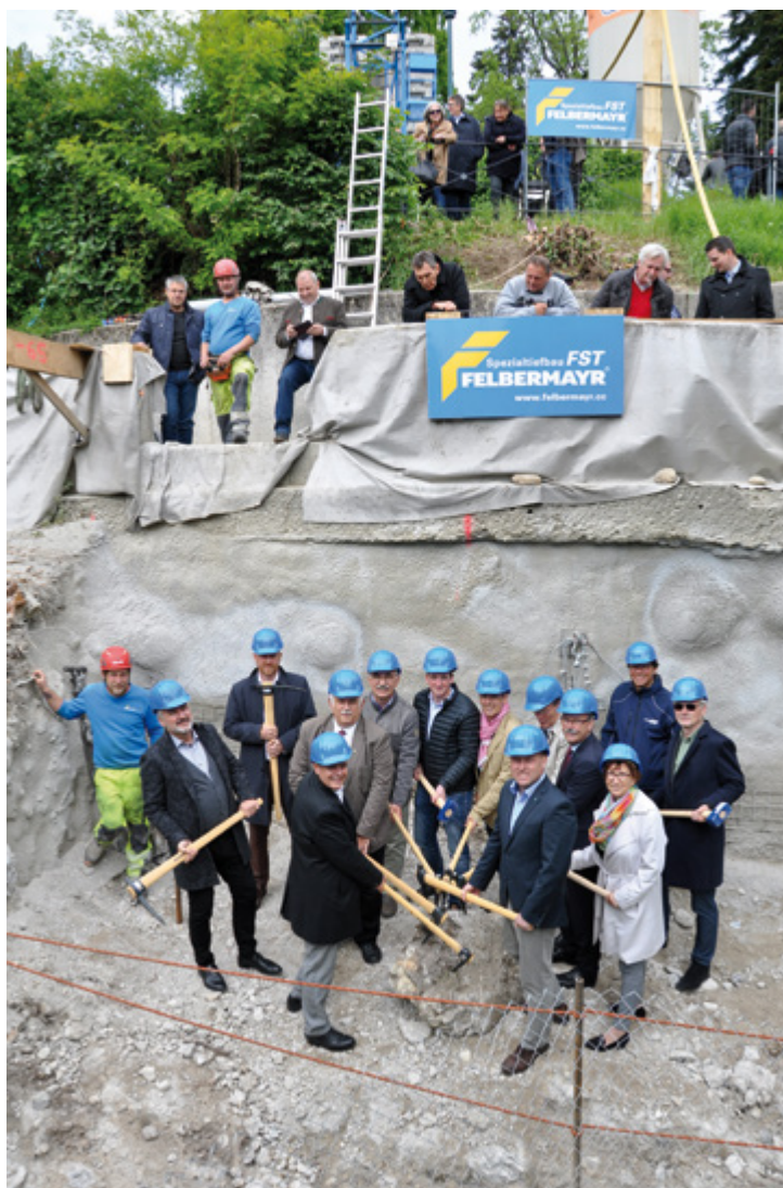
Bürgermeister Gerald Hackl und Ehrengäste bei der sogenannten bergmännischen Anschlagfeier für den Bau des Panoramaliftes. Der neue Lift auf den Tabor ist eines der Großprojekte, die in der bisherigen, zehn Jahre dauernden Amtszeit des Stadtchefs in Angriff genommen oder realisiert wurden.
