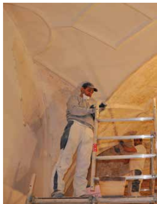
Mittelgewölbe: Die obersten Farbschichten an den Gewölben werden der Gewölbegrate wieder deutlich zum Vorschein kommen.
