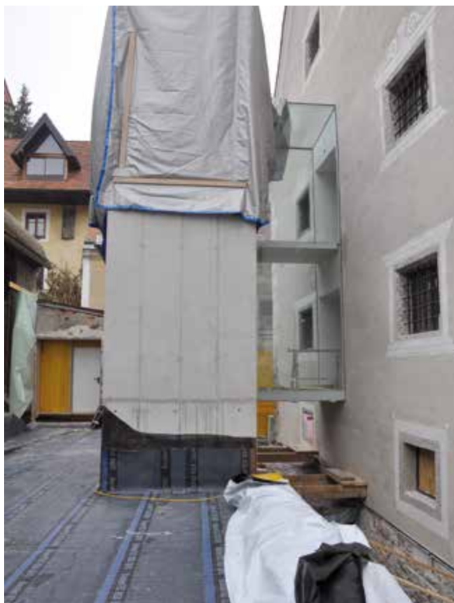
Blick in den rückwärtigen Innenhof: Damit das Museum künftig barrierefrei erreichbar ist, wurde ein Aufzug eingebaut. Er rückt von der Fassade ab, damit diese in ihrem Erscheinungsbild nicht gestört wird. Der Verbindungssteg aus Glas zwischen Innerberger Stadl und Lift ist bereits vorhanden.
