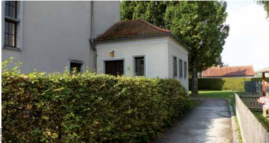
Die WC-Anlage bei der Steyrer Leichenhalle wird generalsaniert. Von 14. Jänner bis 31. Mai 2019 muss die Toilette deshalb gesperrt werden. Ein Sanitärcontainer wird als Ersatz aufgestellt.
