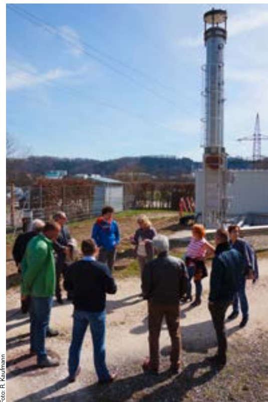
Bei einer Besichtigung der Reststoff-Deponie erläutert RHV-Geschäftsführerin DI Anita Schürer-Wizani (5. v. re.) Mitgliedern des Stadtsenates und des Umweltausschusses Details der Deponie-Technik.
