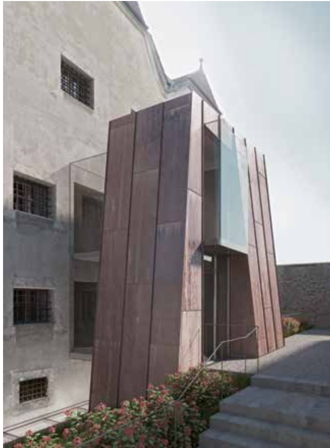
Der Innerberger Stadl wird derzeit für die Landesausstellung 2021 restauriert und umgebaut. Die Grafik zeigt den Lift, eine Konstruktion aus Stahl und Glas mit Kupferverkleidung, der im Innenhof des Stadtmuseums entstehen soll.
