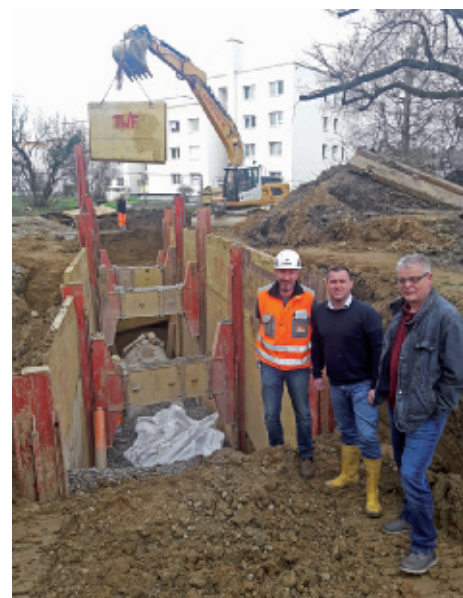
Das Großbauprojekt „Abteilungskanal Tabor“ befindet sich in der Endphase. Der letzte Kanal-Abschnitt, der von der ehemaligen Haupteinfahrt der Trollmannkaserne im Bereich Rooseveltstraße bis zum Einkaufszentrum „Taborland“ verläuft, wird derzeit verlegt. Auf dem Bild (von links): Markus Weissengruber (Polier der Baufirma), Vizebürgermeister Dr. Helmut Zöttl, Ing. Josef Popp (Bauleiter von der Magistratsabteilung für Tiefbau)
