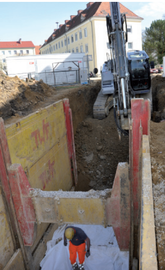
Die in Kies eingebetteten Kanalrohre werden mit Erdrich bedeckt.
