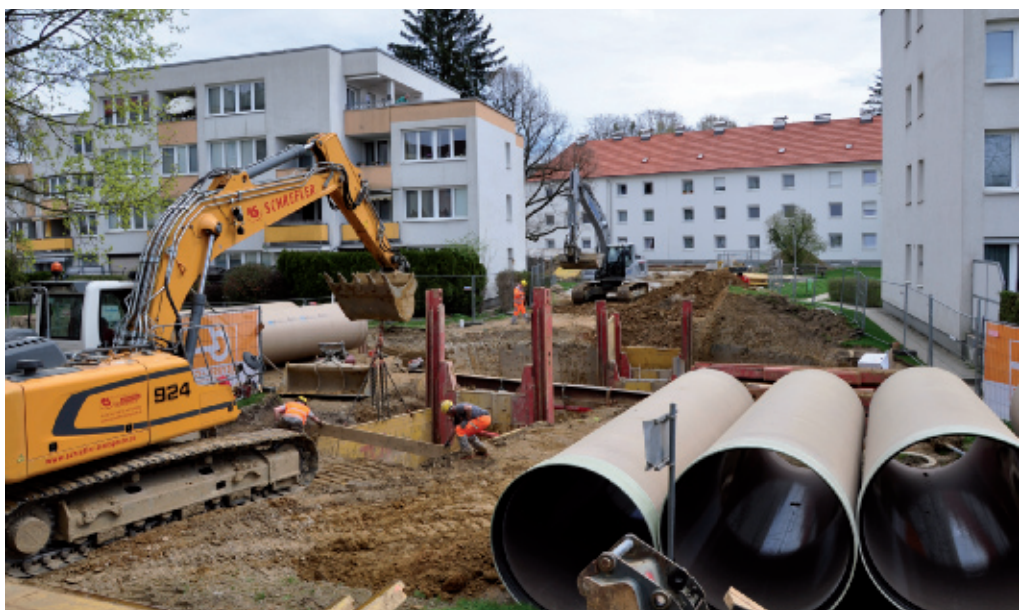
Beeinträchtigungen durch eine Kanalbaustelle mitten im Wohngebiet – den geduligen Anrainern gebührt besonderer Dank für das aufgebrachte Verständnis während der Bauzeit.
