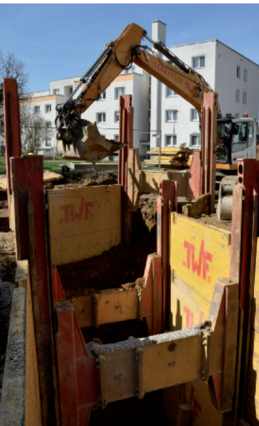
Hier in der Azwangerstraße biegt der Kanal in Richtung Paulmayrstraße ab.
