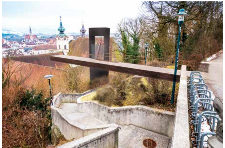
Die Zugangs- und Aussichtsplattform des künftigen Liftes beim Taborturm. Die Taborstiege mit ihren 241 Stufen bleibt bestehen.
