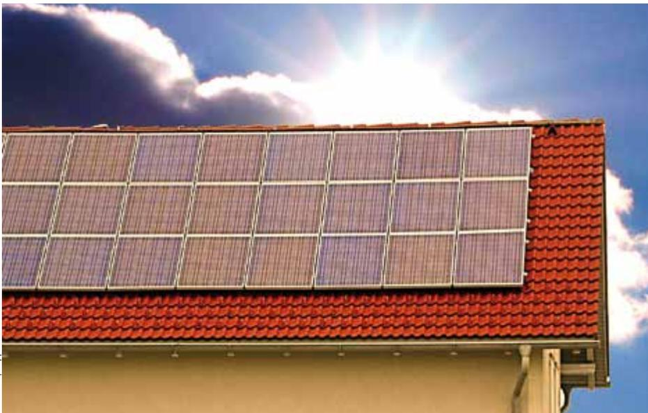
Eine etwa 7 bis 10 Quadratmeter große PV-Anlage liefert etwa 1 kWp Spitzenleistung und bietet einen Stromertrag von bis zu 1100 kWh pro Jahr (ein Vier-Personen-Haushalt benötigt etwa 3500 bis 5000 kWh Strom).
