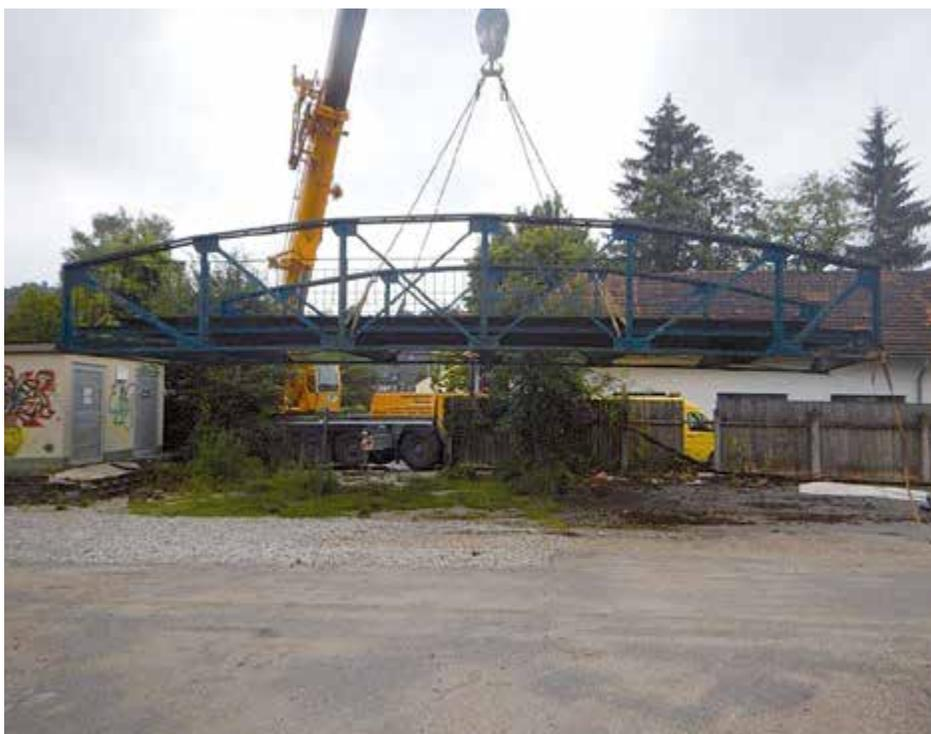
Die alte Gaswerkbrücke im Stadtteil Wehrgraben muss saniert werden. Dazu wurde die Brücke mit einem Kran aus den Brückenlagern gehoben. Sie wird nun auf dem ehemaligen Gaswerkgelände wieder instand gesetzt.
