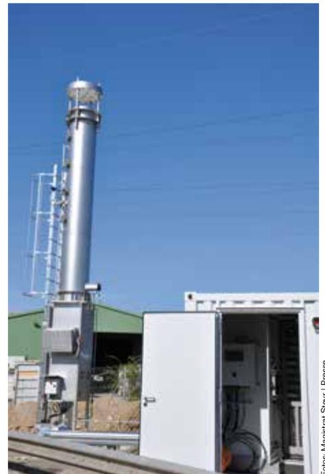
Die Deponiegase werden in der Anlage aufbereitet und über die Gasfackel (links) verbrannt. Rechts im Bild sieht man die elektrische Anlage der neuen Gasstation.
