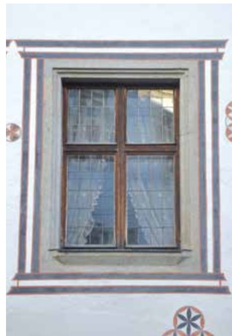
Fenster mit Bleiverglasung. Die Steingewände (Fensterumrahmung) sind charakteristisch für die Renaissance.
