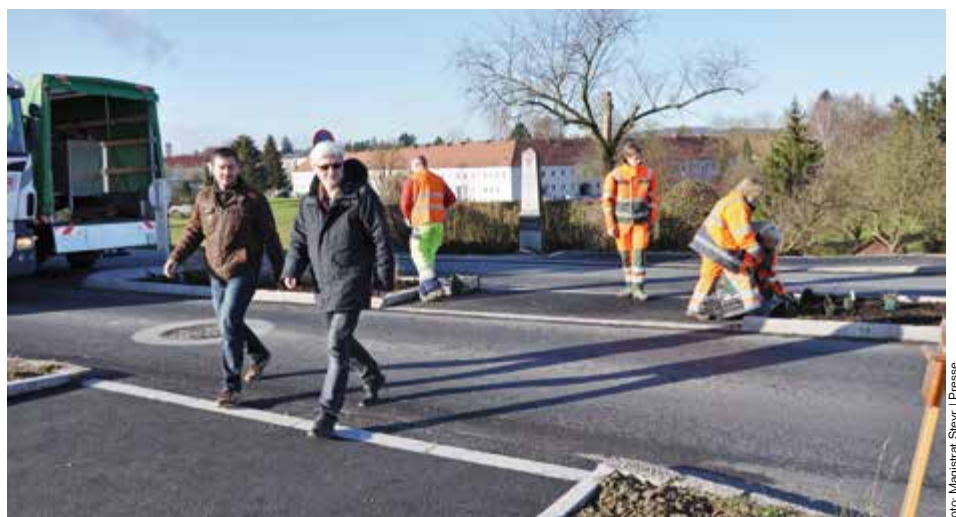
Stadtrat Mag. Reinhard Kaufmann (rechts) und Gemeinderat Thomas Kaliba (links) beim Überqueren der Haager Straße über den neuen Fahrbahnteiler. Im Bild sieht man auch Mitarbeiterinnen und Mitarbeiter der Stadtgärtnerei bei der Bepflanzung der geschaffenen Grüninseln.
