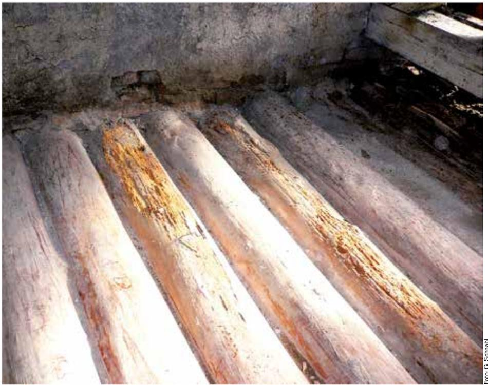
Holz wird in unseren Breiten bereits seit Jahrtausenden beim Bauen verwendet. Das Foto zeigt eine historische Dippelbaumdecke ohne Fußbodenaufbau.
