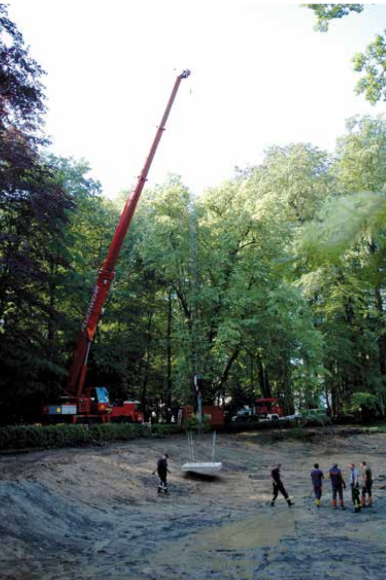
Die 2,5 Tonnen schwere Grundplatte für das Wasserspiel wird mit dem Schwerlastkran in den Teich gehoben.
