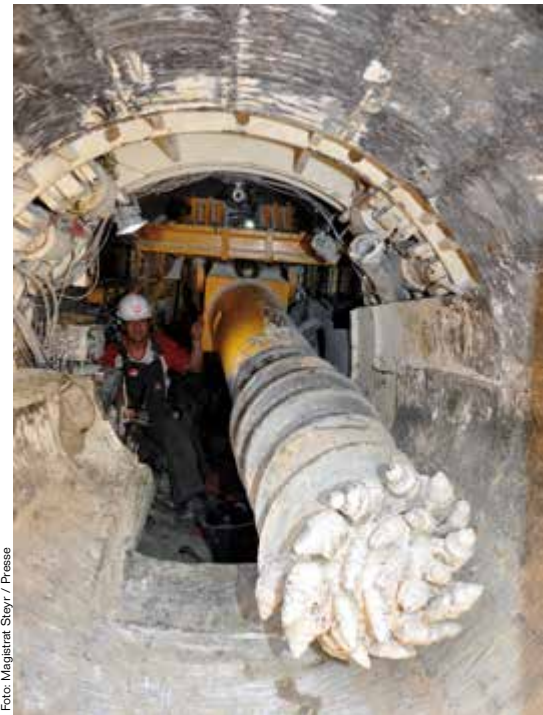
Bohrmeister René Böhnisch an der Bohrmaschine im Vortriebsrohr.
