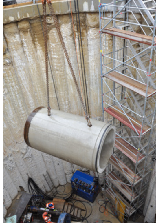
Das letzte Kanalrohr wird in die Startgrube in der Kaplangasse gehoben.
