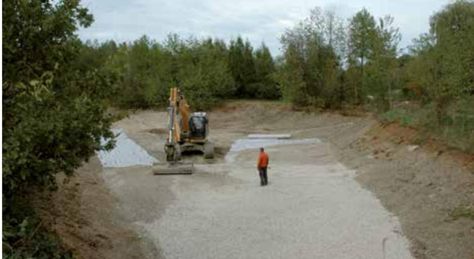
Das Bild zeigt die Gestaltung des Unterbaues im Absetzbecken der Stadtgutteiche. Das Vlies mit der Schotterpackung soll ein zu schnelles Versickern im Absetzbecken verhindern.
