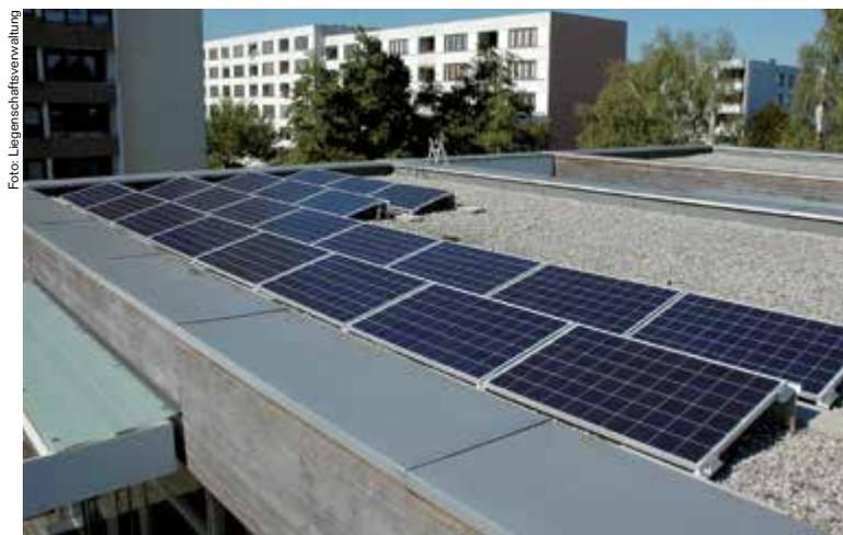
Auf dem Dach der Volksschule Resthof wurde eine Photovoltaik-Anlage errichtet. Der damit gewonnene Strom wird direkt vor Ort verbraucht und nicht ins Netz eingespeist.
