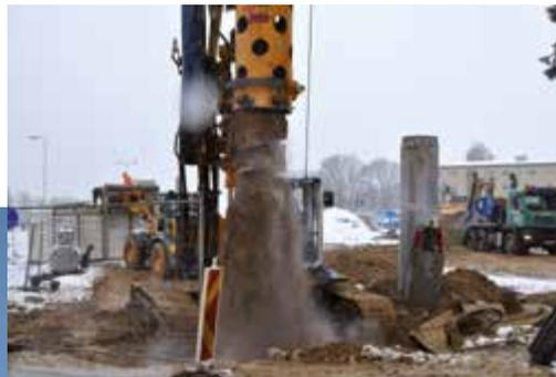
Die Startgrube vor dem Ausbaggern, die Betonbohrpfähle sind bereits gesetzt.
