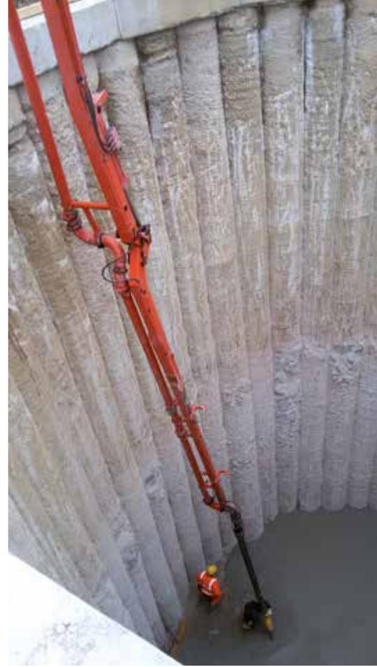
In 15 Metern Tiefe wird die Bodenplatte der Startgrube betoniert.
