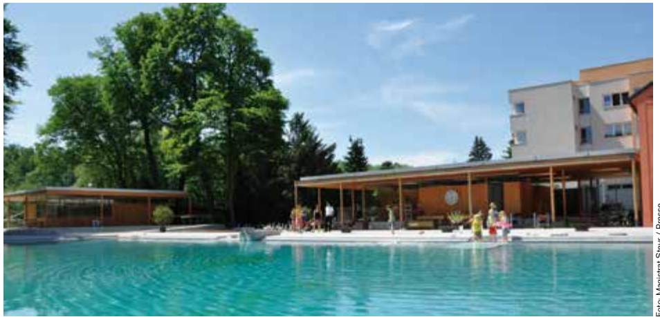
Die Schwimmschule nach der gelungenen Revitalisierung.
