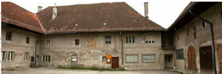
Der Innenhof des denkmalgeschützten alten Schlüsselhofs – der Gebäudeteil mit dem Fresko (Bildmitte) stammt in seinem Kern aus dem 15./16. Jahrhundert.
