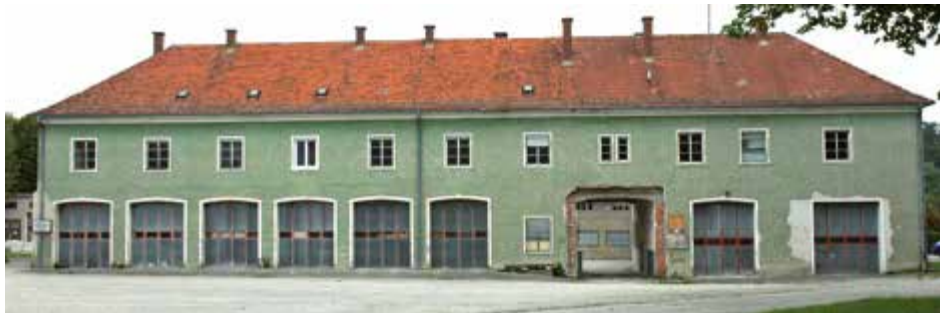
Die Front-Ansicht des Schlüsselhofs
