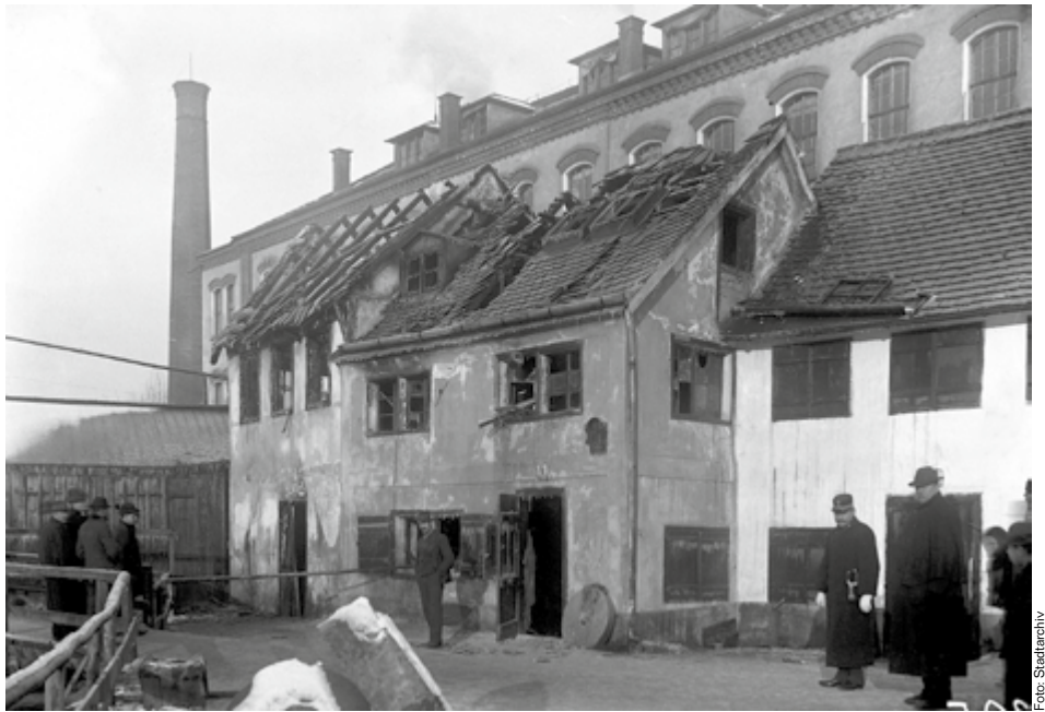
Das Foto aus dem Jahr 1913 zeigt das Objekt IX der österreichischen Waffenfabrik im Steyrer Wehrgraben. Bei einem Brand am 1. Mai 1913 ist der linksseitige Trakt des Bauwerks zerstört worden.
