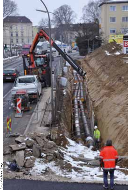
Die Stadt Steyr arbeitet neuerdings mit der Fernwärme Steyr GmbH zusammen, damit die Energieträger Erdgas und Fernwärme optimal genutzt werden können. Am Bau des Fernwärme-Leitungsnetzes wird bereits seit dem Vorjahr mit Hochdruck gearbeitet.
