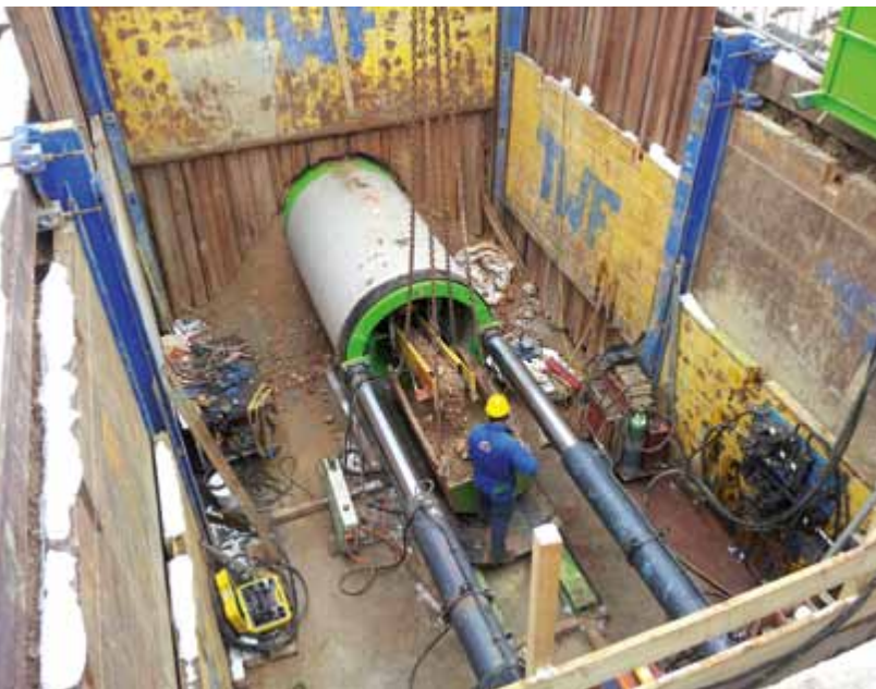
Der Voraushub für die Kanaltrasse
