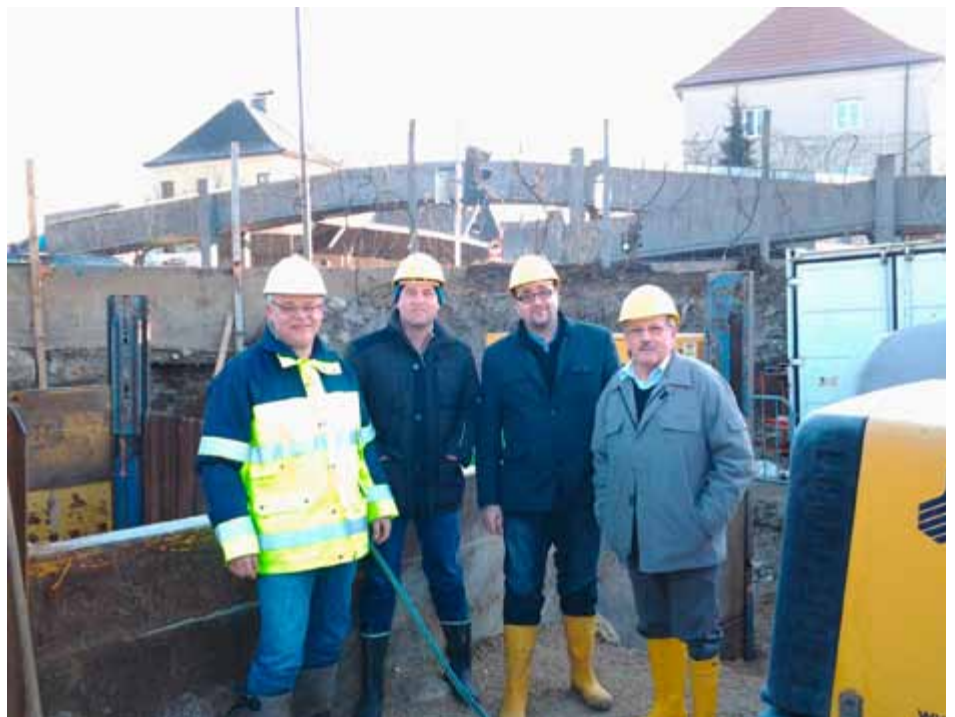
Vor Kurzem haben wir uns über den Baufortschritt bei den Kanalbauarbeiten auf dem Kasernengelände informiert – auf dem Foto (v. l.): Ing. Josef Popp (Tiefbau-Abteilung Magistrat Steyr), Stadtrat Dr. Helmut Zöttl, Uwe Pichler (FPÖ-Bezirksgeschäftsführer) und Gemeinderat Roman Eichhübl.
