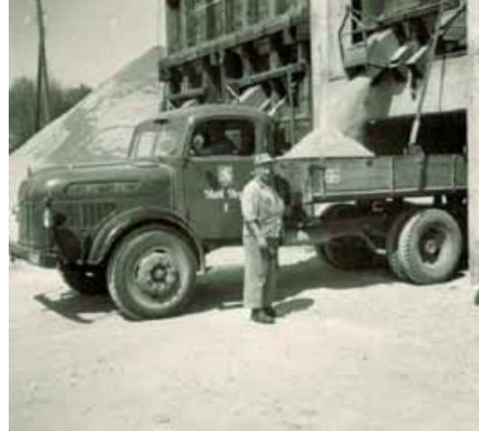
Im Schotterwerk erzeugter Sand und Split werden in einen Lkw gefüllt und für die Erhaltung bzw. Errichtung der Straßen verwendet.
