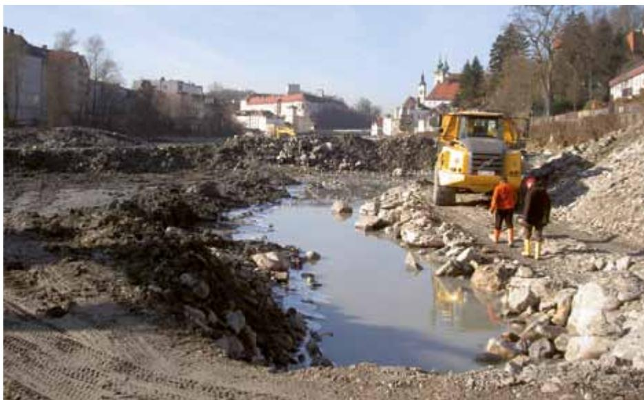
Als dritter Teil des Hochwasserschutz-Programms für Steyr wurde die Enns im Bereich Rederbrücke eingetieft. Insgesamt 300.000 Tonnen Material (140.000 Kubikmeter) wurden weggeschafft.
