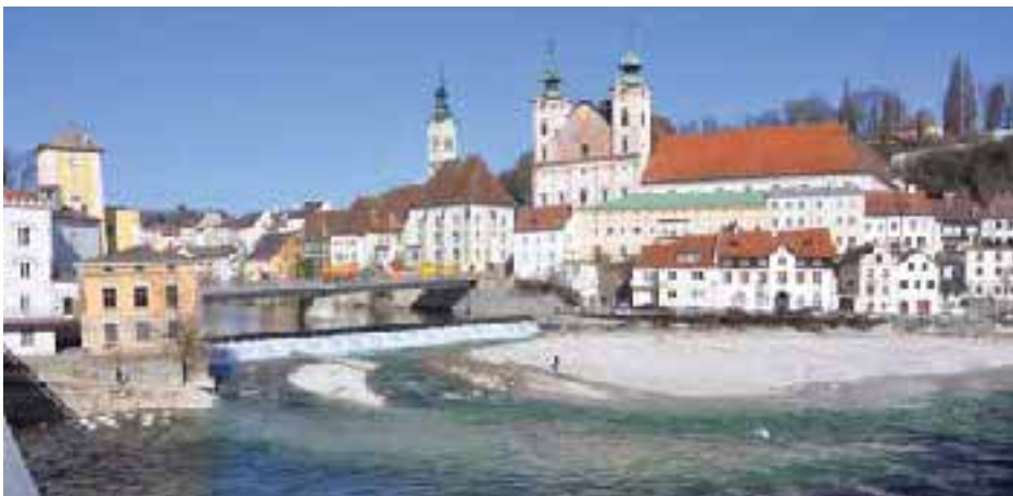
Der Charakter des Enns-Flusses hat sich durch die Hochwasserschutz-Arbeiten verändert.
