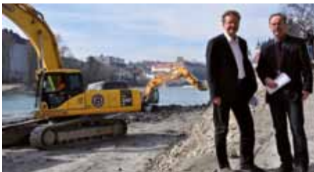
Landesrat Rudi Anschöber (links) und Bürgermeister Gerald Hackl (rechts) besichtigten vor kurzem die Hochwasserschutz-Baustelle an der Enns.
