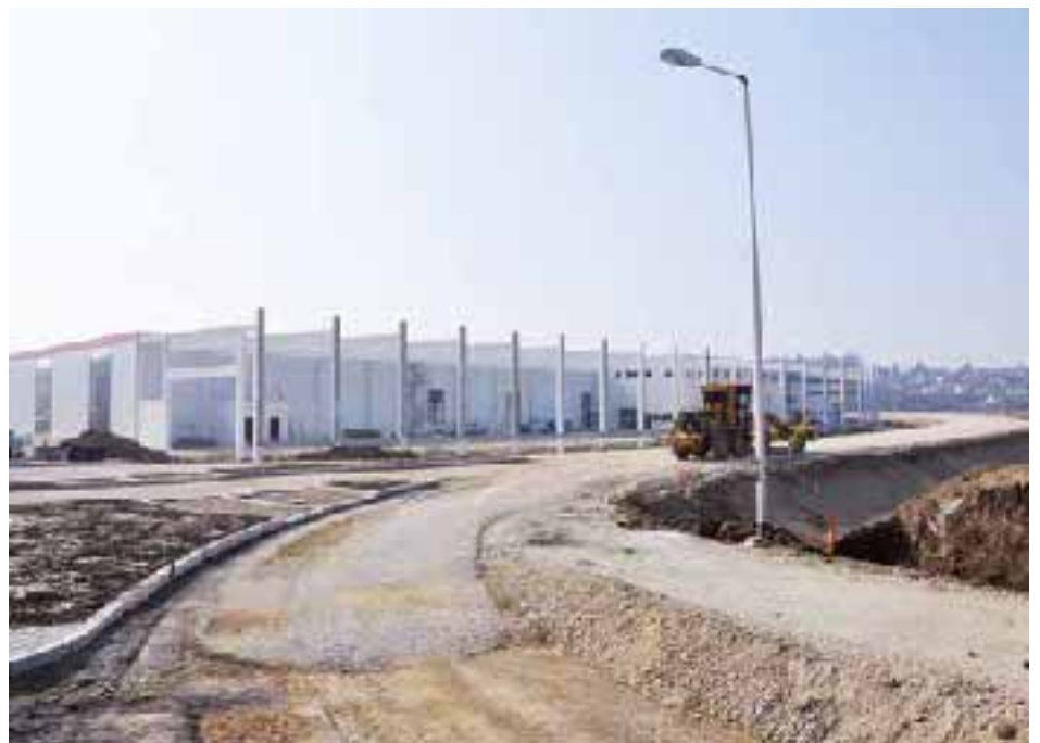
Auf dem Foto im Vordergrund die im Bau befindliche Zufahrt zum neuen Bauhaus an der Ennser Straße. Hier beginnt die Trasse der zukünftigen Steyrer Westspange.
