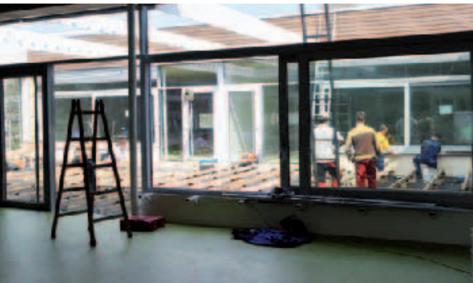
Die Arbeiten im Innenbereich der Volksschule Resthof gehen zügig voran. Das Bild zeigt einen Klassenraum mit der angrenzenden Terrasse.
