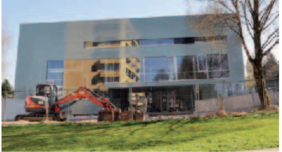
Blick auf den Eingangsbereich der neuen Volksschule Resthof
