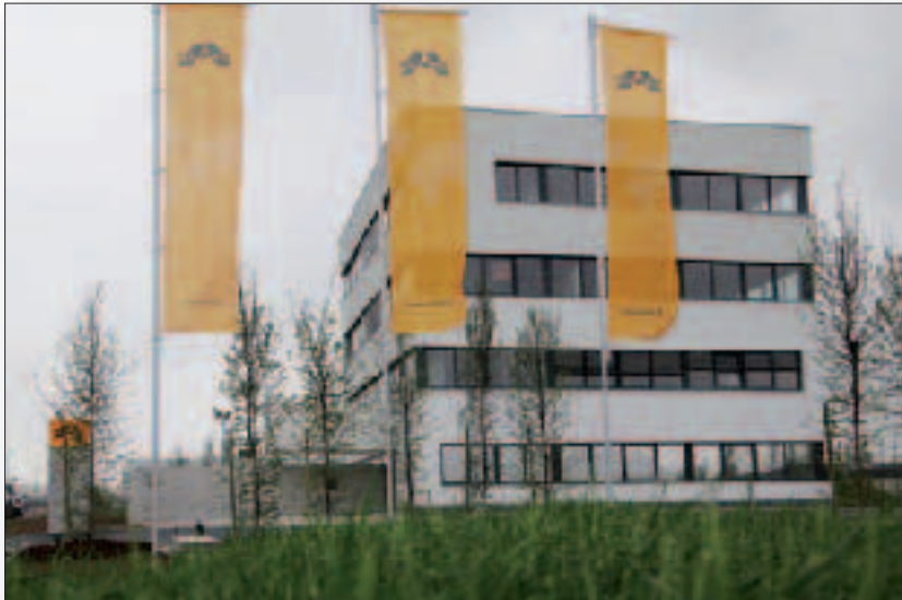
Das neu errichtete Bürogebäude der Alpine erfüllt alle modernen Anforderungen.
