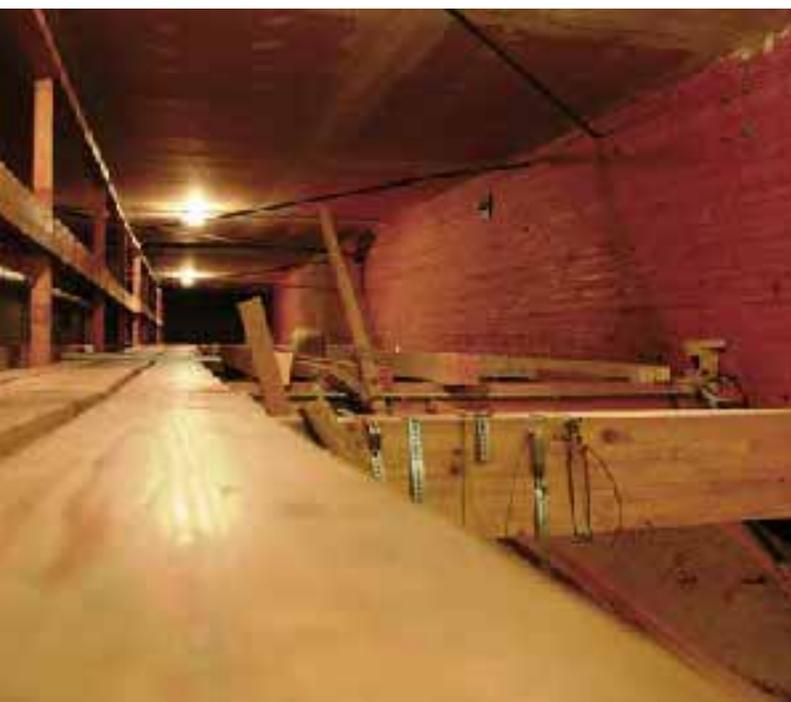
Großes Sanierungsprojekt im Stadtsaal: Sowohl die Dachkonstruktion als auch die Leimbänder (ganz rechts im Bild zu sehen) werden erneuert.
