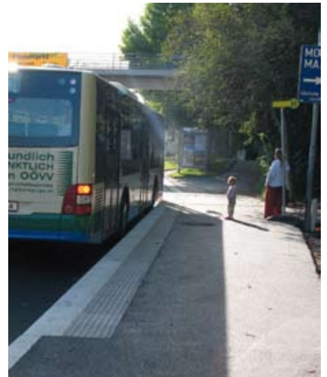
Die Sanierung weiterer Bushaltestellen wurde durchgeführt – auf dem Bild: die Bushaltestelle der Linie 2 zum Krankenhaus. Sie wurde behindertengerecht umgebaut.
