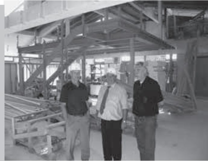
Die Rohbauarbeiten im Amtsgebäude Reithoffer sind größtenteils abgeschlossen. Auf dem Foto sind die Stahlbauten in den Obergeschossen zu sehen.
