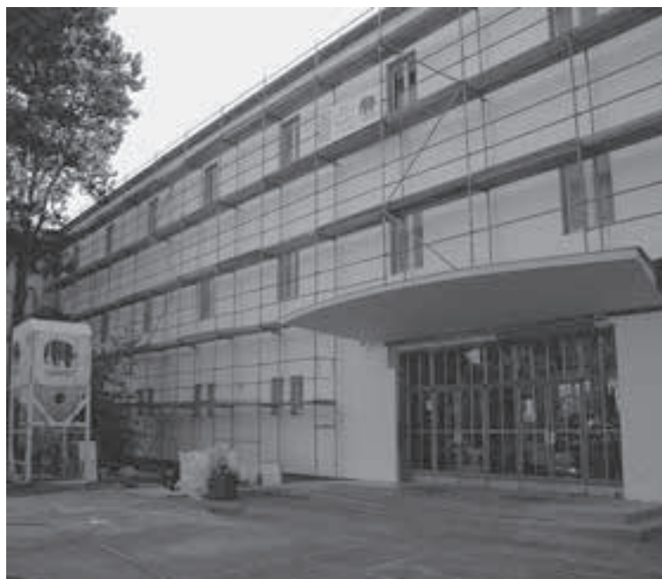
An der Ennsleitschule wurde die Sanierung der Außenfassade inkl. Fenstertausch durchgeführt.
