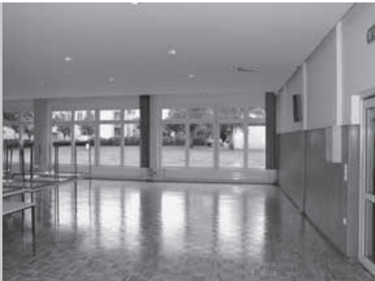
Im Mehrzwecksaal Münchenholz wurden während der Sommermonate der Innenraum und die Sanitäreinrichtungen saniert. Außerdem wurde der Heizkessel ausgetauscht und eine Umstellung von Heizöl leicht auf Gas durchgeführt.
