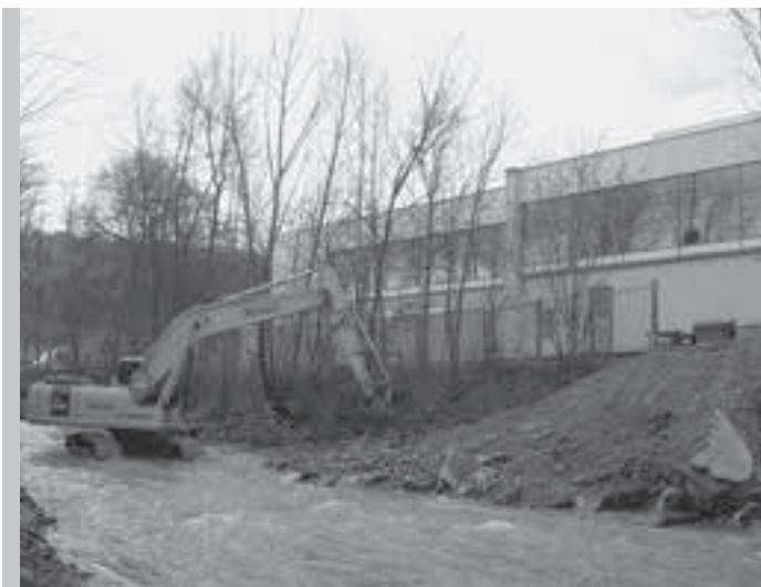
Anfang Februar wurde mit dem Bau des Hochwasserschutzes beim Ramingbach begonnen. Stadtbadseitig werden Mauern und ein Damm errichtet.
