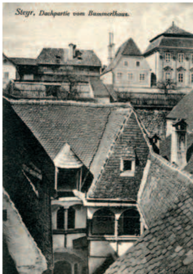
Diese Ansichtskarte mit dem Titel „Dachpartie vom Bummerlhaus“ stammt aus dem Jahr 1943. Im Hintergrund sind Häuser an der Berggasse zu sehen.
