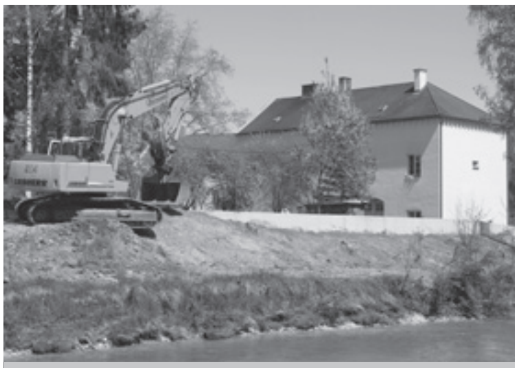
Die Bauarbeiten für den Schutzdamm entlang des Gsangwassers werden bis Ende Mai abgeschlossen sein. Der Damm soll verhindern, dass die Steyr bei Hochwasser zwischen Kugelfang und Kalkofenbrücke ins obere Eysfeld eindringen kann.
