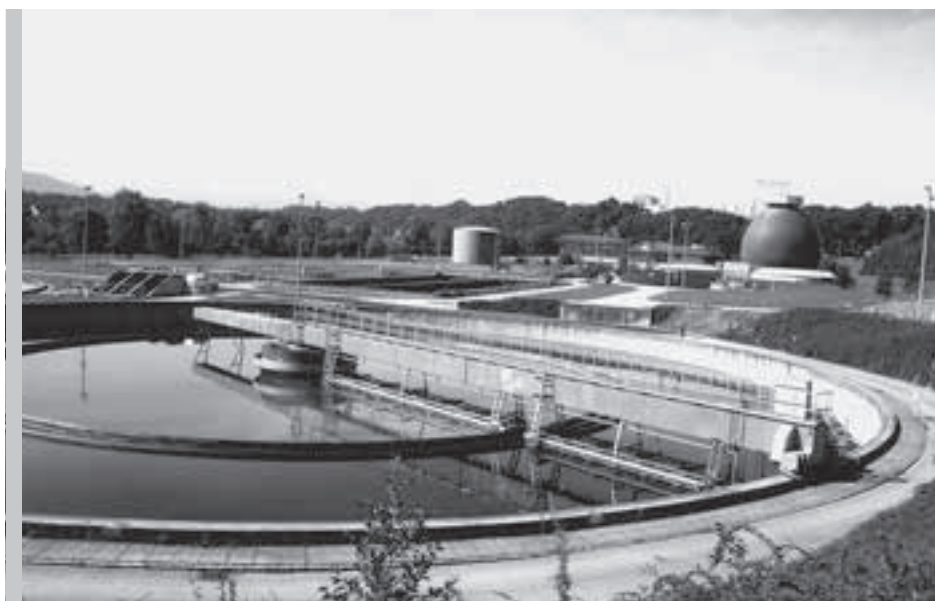
Die Reinigungsleistung der Zentralen Kläranlage lag immer weit über den gesetzlichen Vorgaben. Das wirkt sich auch auf die Güteklasse des Ennsflusses aus. Im Bild eines der großen Nachklärbecken der Zentralen Kläranlage.
