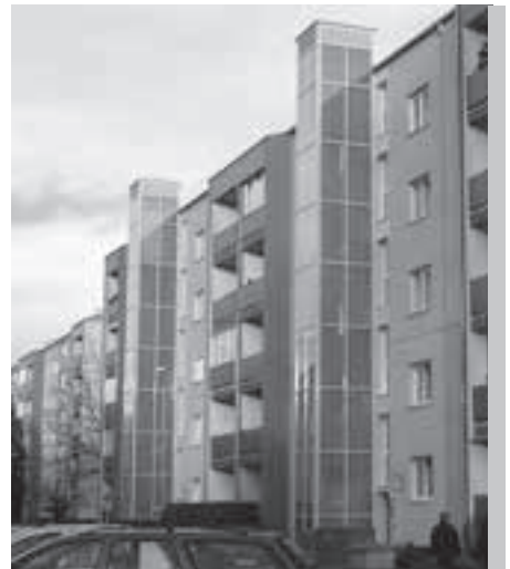
Die GWG der Stadt Steyr hat bereits 39 Wohnhäuser nachträglich mit Lifteinrichtungen ausgestattet. Bis zum Jahr 2009 soll es in Steyr insgesamt 115 Objekte mit nachträglich eingebauten Aufzügen geben.
