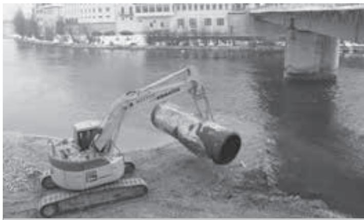
Erste Hochwasserschutzmaßnahme in der Enns: Im Bereich Zwischenbrücken wird der Steinwurf beim Mittelpfeiler der Ennsbrücke entfernt. Im Bild die Errichtung eines Dammes zum Mittelpfeiler. Die Arbeiten können nur bei Niedrigwasser der Enns durchgeführt werden.
