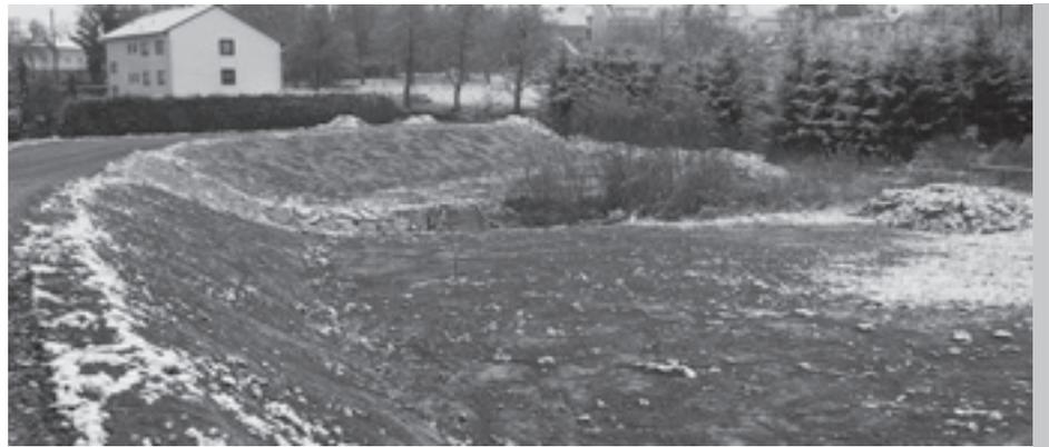
Das Rückhaltebecken für den Dorningerbach in Gleink ist seit kurzem fertig. Der Damm erfüllt bereits seine Funktion. Der Straßenbau wird nach eventuellen Setzungen durchgeführt.
