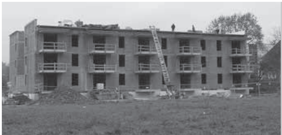
30 neue Mietwohnungen speziell für ältere Menschen: Die Bauarbeiten für das Vorhaben „Betreubares Wohnen“ in Münichholz laufen auf Hochtouren. Die Anlage, die im Herbst 2006 fertig sein soll, wird von der Gemeinnützigen Wohnungsgesellschaft (GWG) gleich neben dem Alten- und Pflegeheim errichtet.
