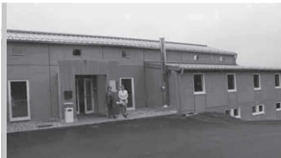
Die neue Unterkunft für entlaufene, ausgesetzte oder beschlagnahmte Tiere auf dem Gelände des alten Tierheims im Stadtteil Gleink. Der Neubau wurde nach modernsten tierschutzrelevanten Erkenntnissen errichtet.
