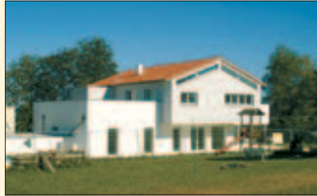
Wohnhaus (2004) nahe Schläuslmaysiedlung
