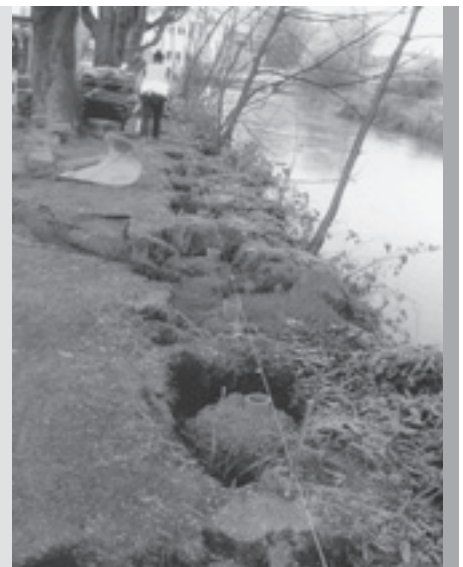
Im Bereich der Wehrgrabengasse werden Schäden in der Fahrbahn und am Ufer ausgebessert. Auf dem Foto: die Fundamente für das neue Eisengeländer.
