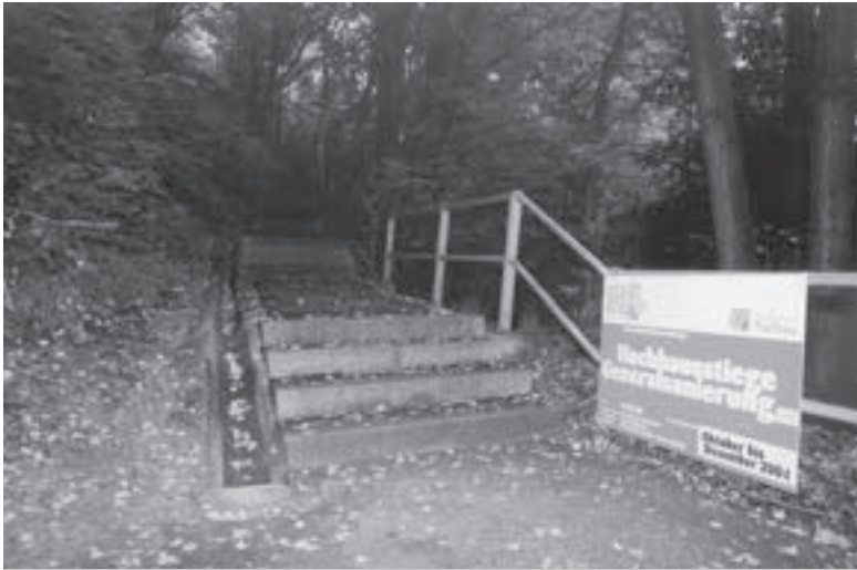
Die Hochhaus-Stiege (Bild), die auf den südlichen Teil der Ennsseite führt, ist wegen Sanierungsarbeiten bis etwa Mitte November gesperrt. Der Märzenkeller-Übergang und die Ennsleiten-Stiege zur Wokralstraße sind von der Sperre nicht betroffen.
