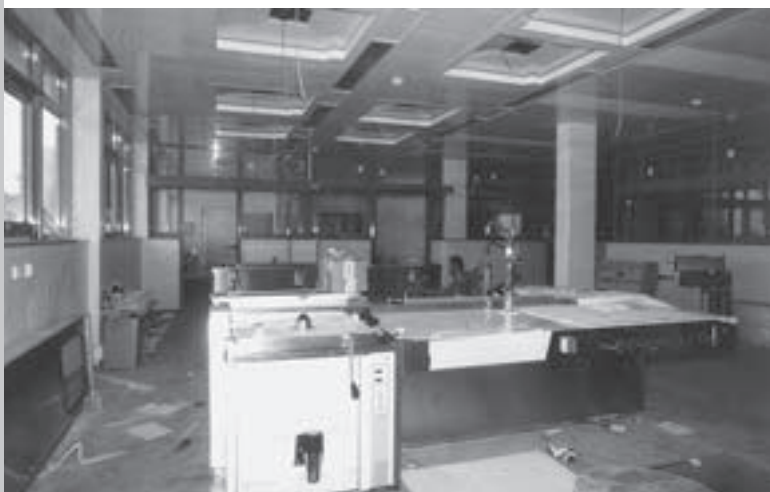
Der Einbau der neuen Küche läuft auf Hochtouren.
